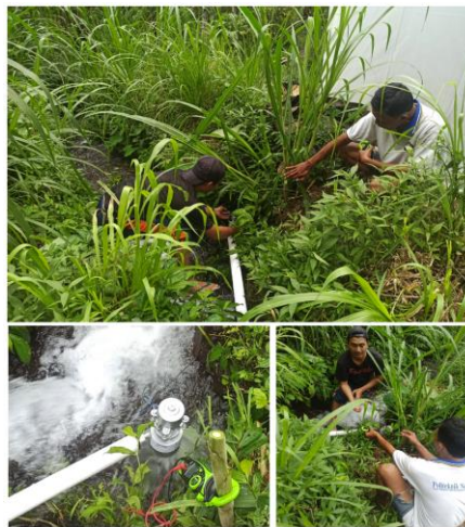
Gambar 4. Pemasangan Pembangkit Listrik Tenaga Mikro Hidro
