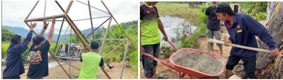
Gambar 6. Pemasangan filter air, pemasangan tower dan pengecoran dengan semen
