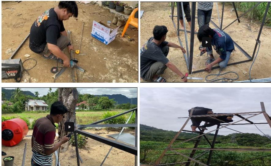
Gambar 5. Pemotongan Besi dan Proses Pengelasan
