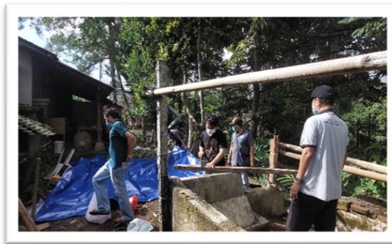
Gambar 2. Pemasangan Kolam Terpal
