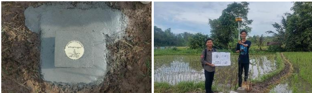
Gambar 12. Kegiatan Pemasangan dan Pengukuran Ulang Pilar Beton Batas Nagari
