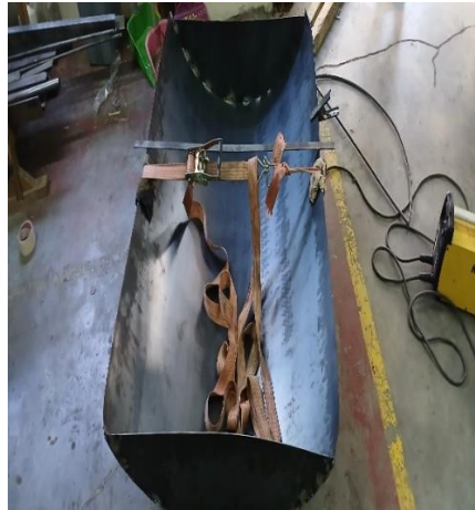
Gambar 4. Pembuatan Bak Penampung Air
