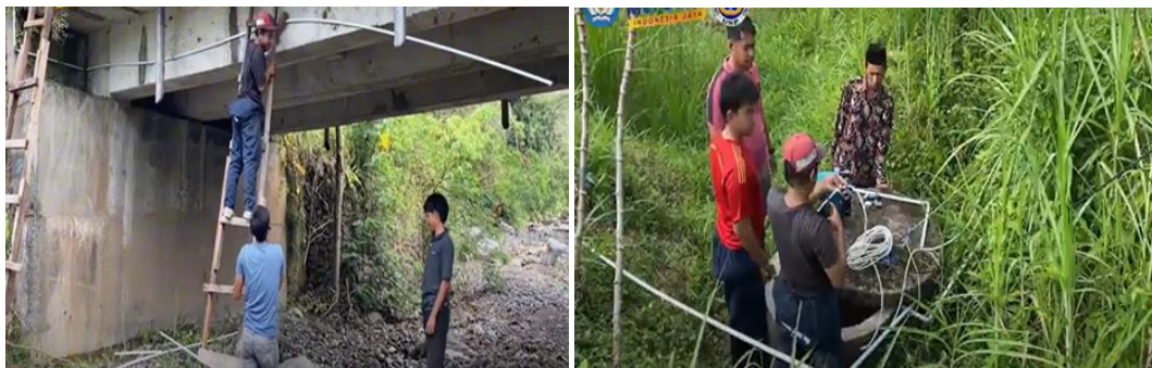
Gambar 6. Pemasangan pipa, mesin air, filter dan sistem penyaringan
