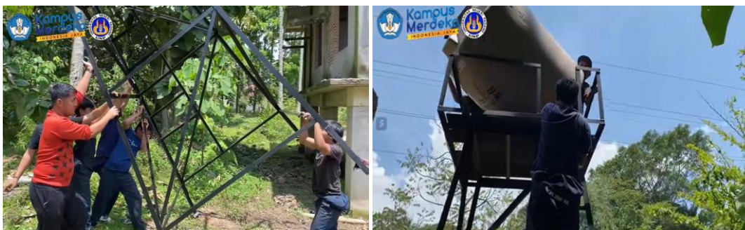
Gambar 7. Pemasangan tower, pengecoran dengan semen, pemasangan tedmon dan uji coba
