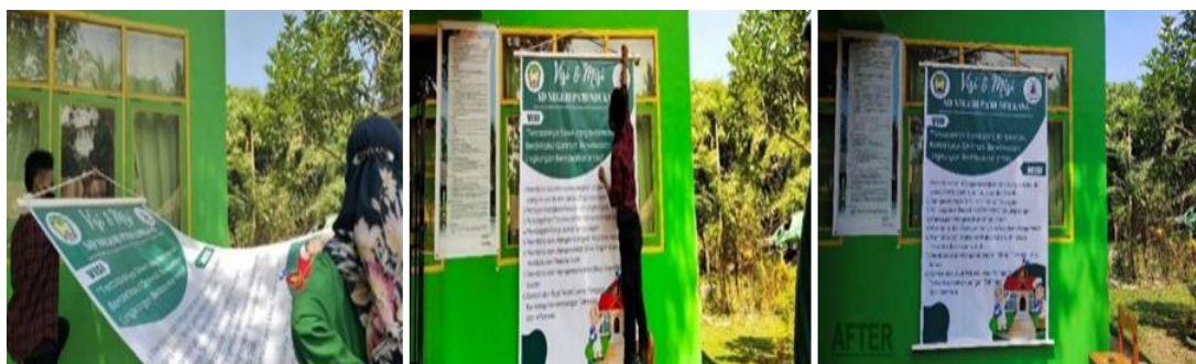
Gambar 8. Proses Pemasangan Baliho Visi Misi
