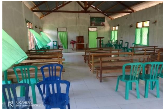
Gambar 8. Kondisi Gereja Setelah Pemasangan Keramik
