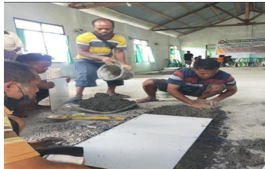
Gambar 7. Pemasangan Keramik
